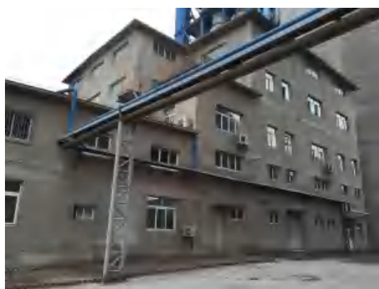
密闭余热发电厂房
