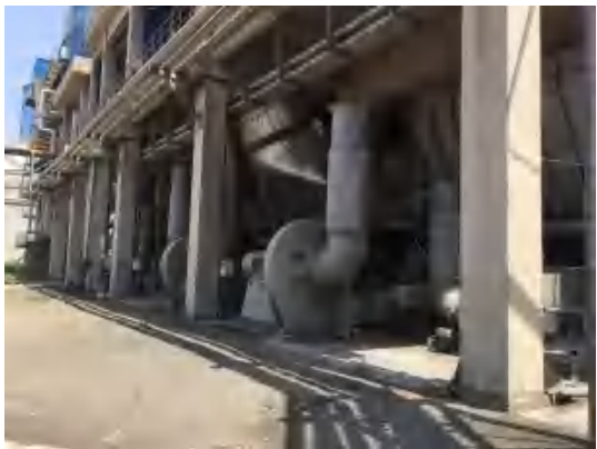
篦冷机高压风机消声器
