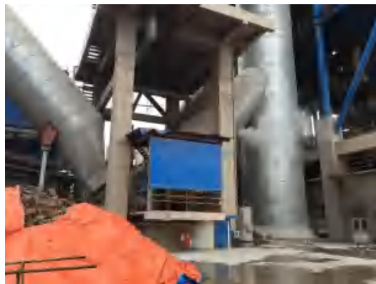
窑尾高温风机隔音板
