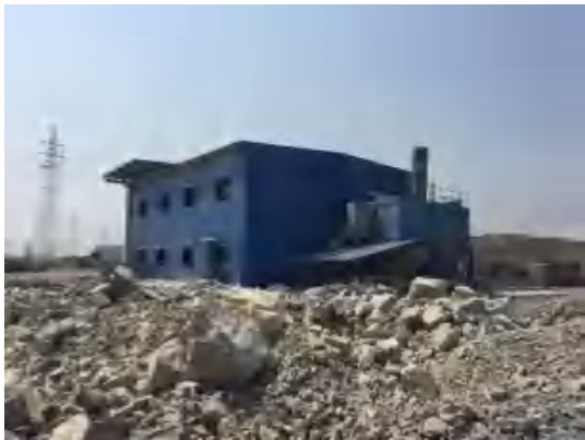
密闭石灰石破碎厂房
