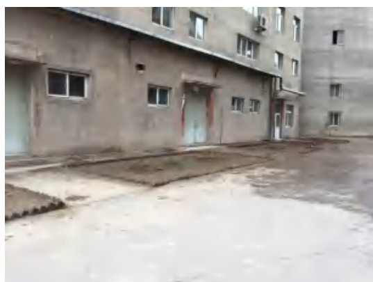
二期余热发电厂房西侧绿化 (2016 年新栽种)
