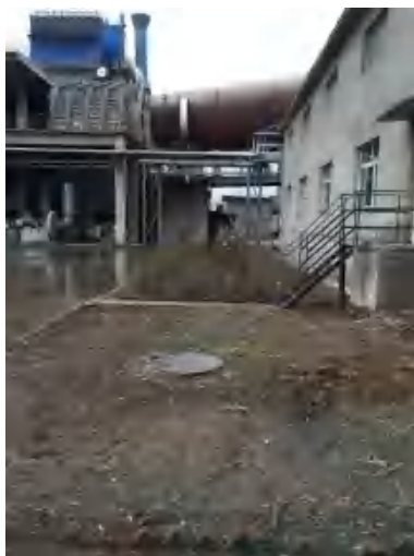
二期余热锅炉水 处理间北部绿化
