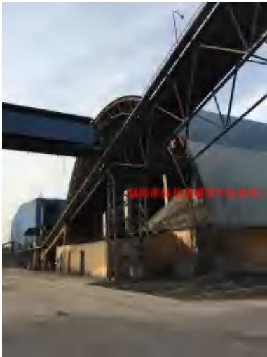
辅助原料及原煤预均化堆场 2
