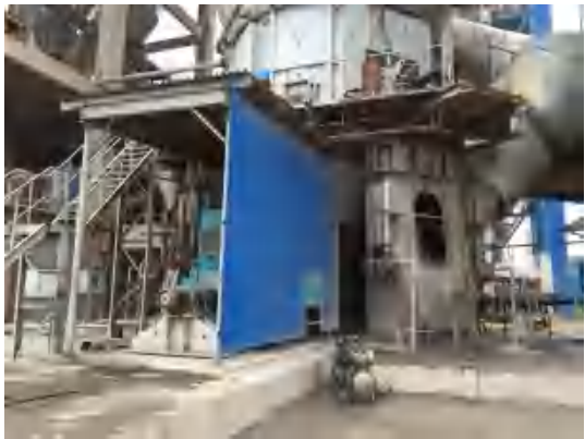
原料磨隔音板
