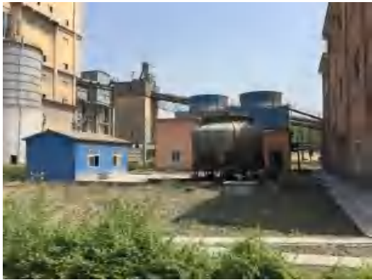
中水处理装置(照片 1)
