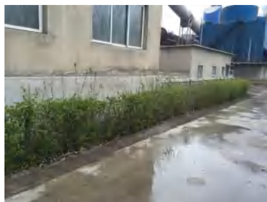
二期空压站、循环水站东侧绿化
