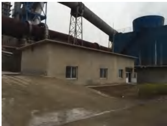
密闭余热发电循环水泵房
