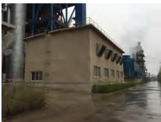
密闭空压机厂房
